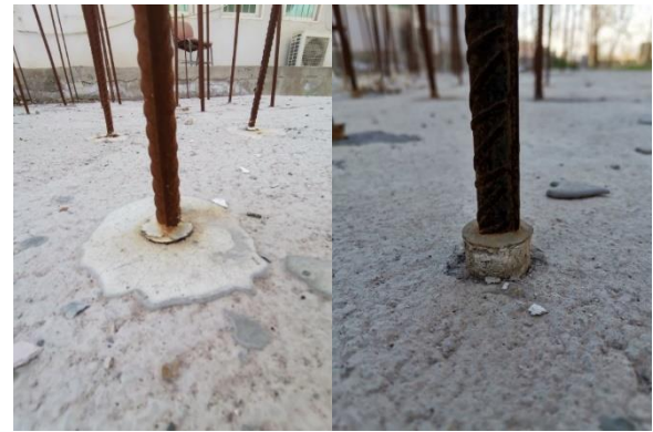
A. Grout B. Adhesive
